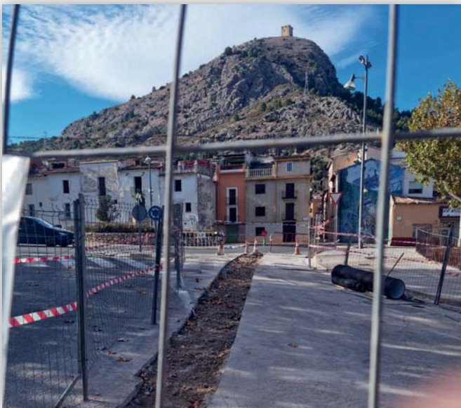
Connexió de la xarxa de sanejament del barranc de Fraga i repavimentació de la zona afectada per les filtracions d'aigua
