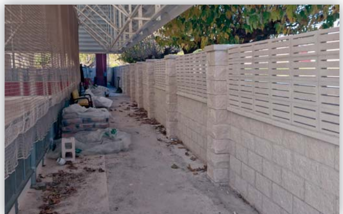
Construcció nou mur piscina municipal
