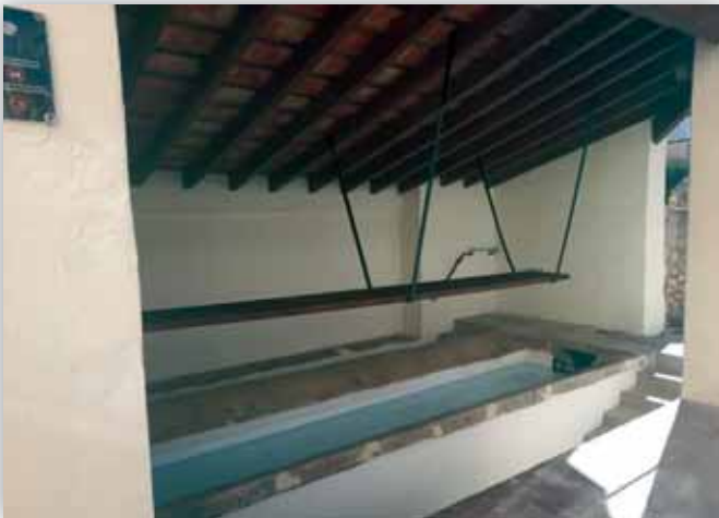
Rehabilitació del llavador de Fraga
