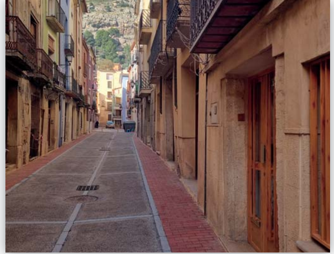
Segueixen a bon ritme les obres als carrers del nucli antic
