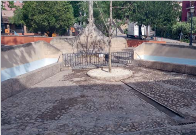
Reparació de l'abeurador del Pla de la Font
