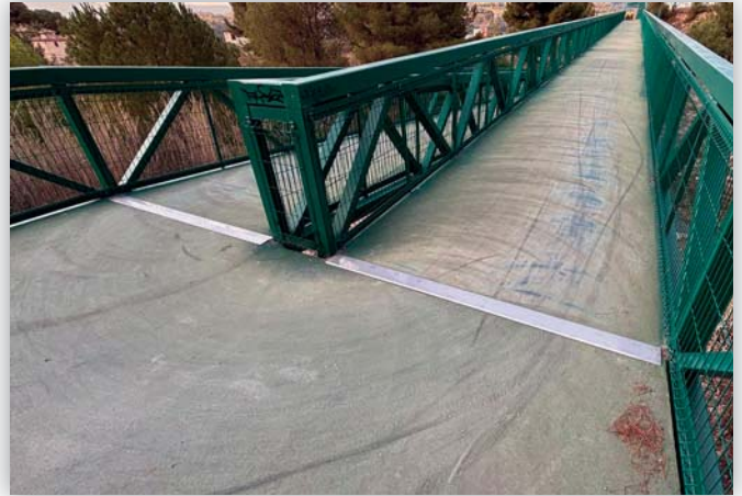
Reparació de les juntes de la passarel·la Via verda
