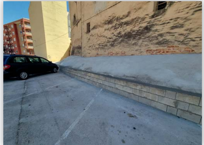
Encofrat i reforçament del mur del recinte de la Fira
