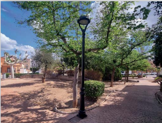
Renovació de les lluminàries
