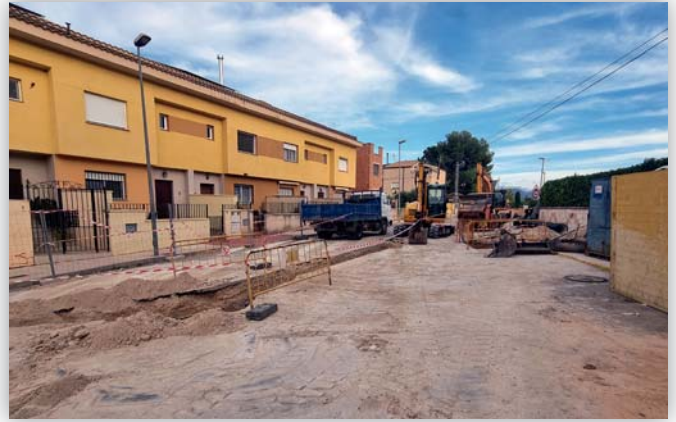
Inici de les obres de renovació de les infraestructures de l'Avinguda Moreres
