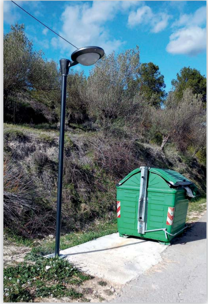
Instal·lació de lluminària solar a Penella
